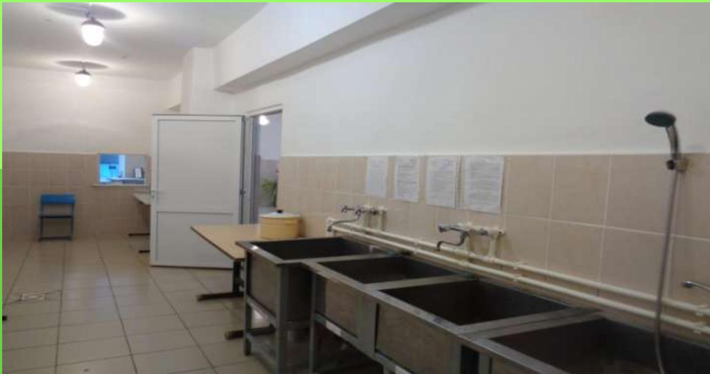
**Моечная предназначена для мытья кухонной и столовой посуды. Освещение в цехе искусственное (посредством люминесцентных ламп). Пол выложен светлой плиткой, стены: нижняя половина – белой плиткой, а верхняя – побелена. В цехе имеются стеллажи для сушки чистой посуды, 1 ванна для мытья кухонной посуды и 3– для мытья столовой посуды (с подводом горячей и холодной воды), посудомоечная машина, большой электроводонагреватель.**
